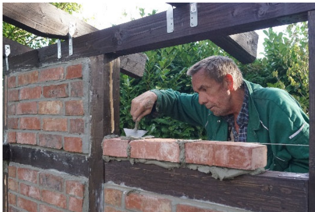
Raimund Biekmann beim Mauern der Remise (Foto Heimatverein).
